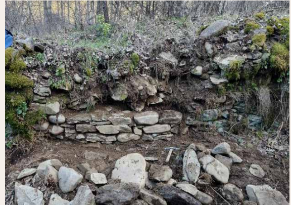
Despejando la zona de pared en mal estado.
