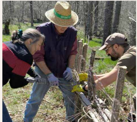
Colocando las ripias para formar las viras del cierro.
