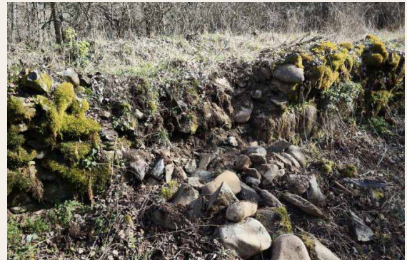
Tramo de pared restaurado.
